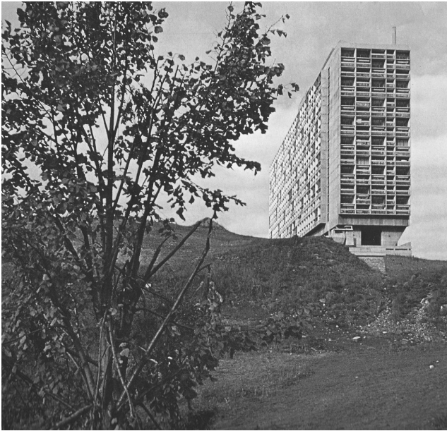
Unité d'Habitation of Firminy-Vert, ( https://www.fondationlecorbusier.fr )
